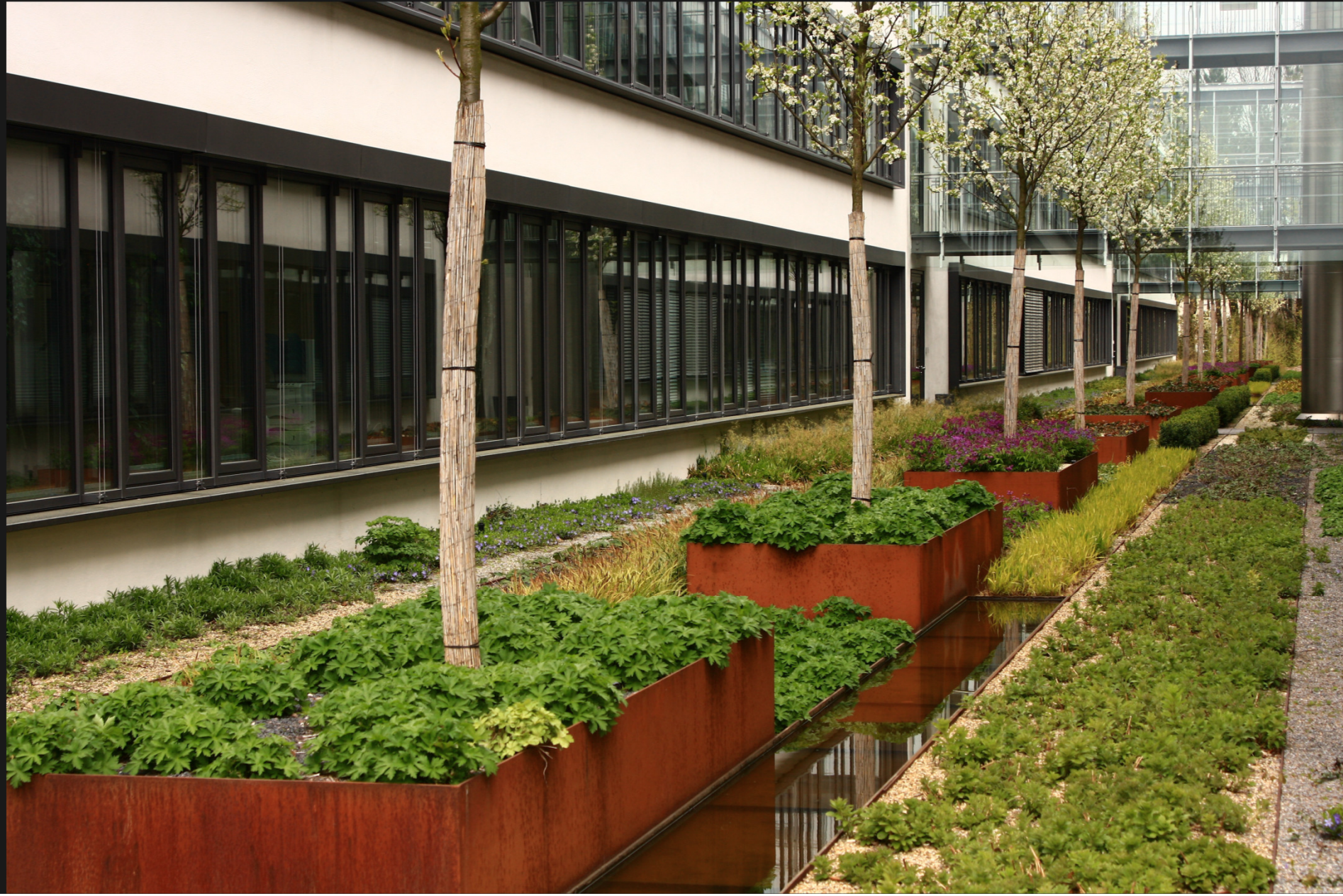
Dachgarten wagnis4 Wamsler Rohloff Wirz Müller FreiRaum Architekten Regensburg
