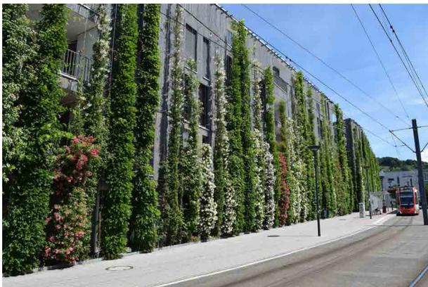
Abb. 6: Bodengebundene Fassadenbegrünung mit Kletterhilfe.
