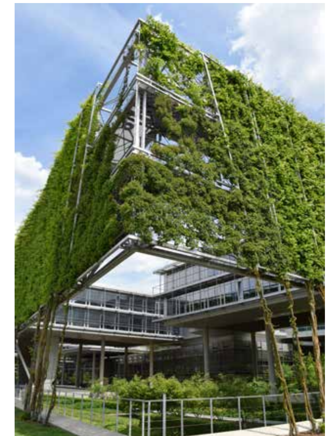
Abb. 30: Bodengebundene Fassadenbegrünungen mit Netzen bzw. Gittern lassen sich gut erfassen ... Quelle: BuGG
