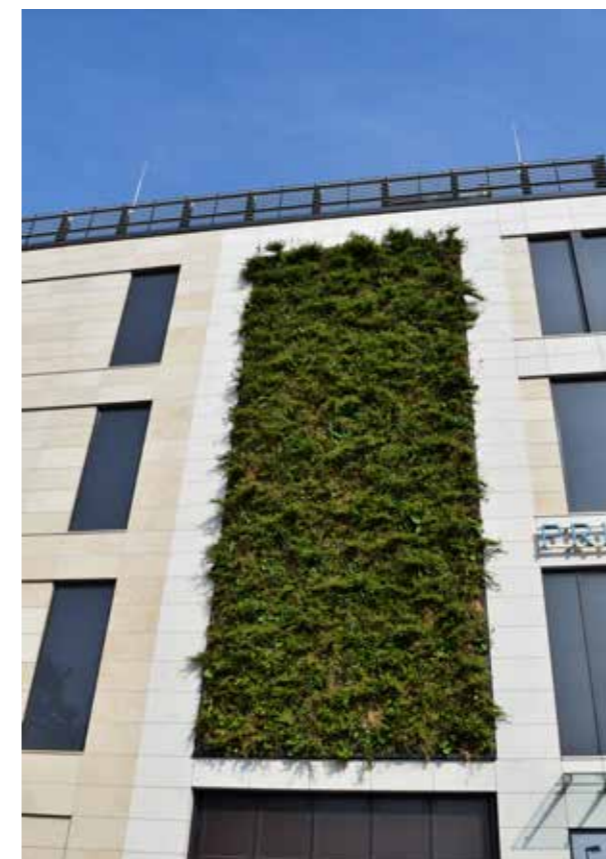
Abb. 31: ... ebenso wie wandgebundene Fassadenbegrünungen. Hier lassen sich die Flächen in Quadratmeter gut ermitteln. Quelle: BuGG
