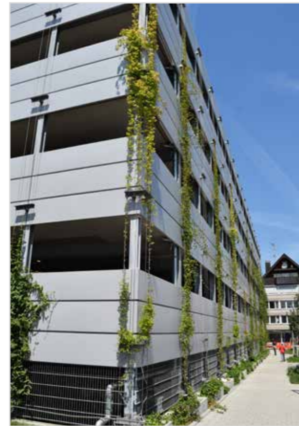
Abb. 29: Es ist nicht immer eindeutig, wie viel Quadratmeter begrünte Wandfläche einem laufenden Meter Kletterhilfe zugeordnet werden kann. Quelle: BuGG
