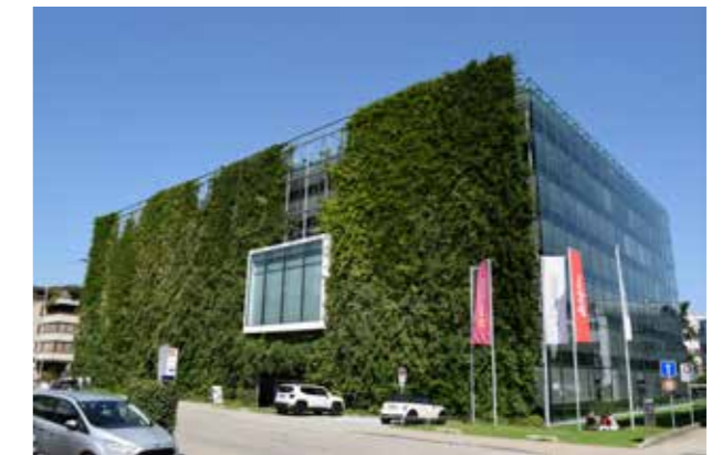
Abb. 6: Bodengebundene Fassadenbegrünung mit Kletterhilfe. Quelle: BuGG
