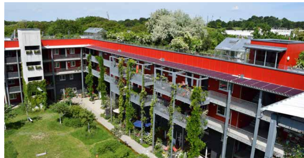
Abb. 42: Verbesserung der Wohnqualität und des Stadtklimas durch Dach- und Fassadenbegrünungen. Quelle BuGG
