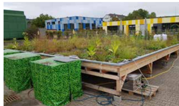
Abb. 47: Das „Projekt EffIN-Grün“ beleuchtet verschiedene Aspekte, u. a. auch die Verdunstungsleistung von Extensivbegrünungen Quelle: BuGG
