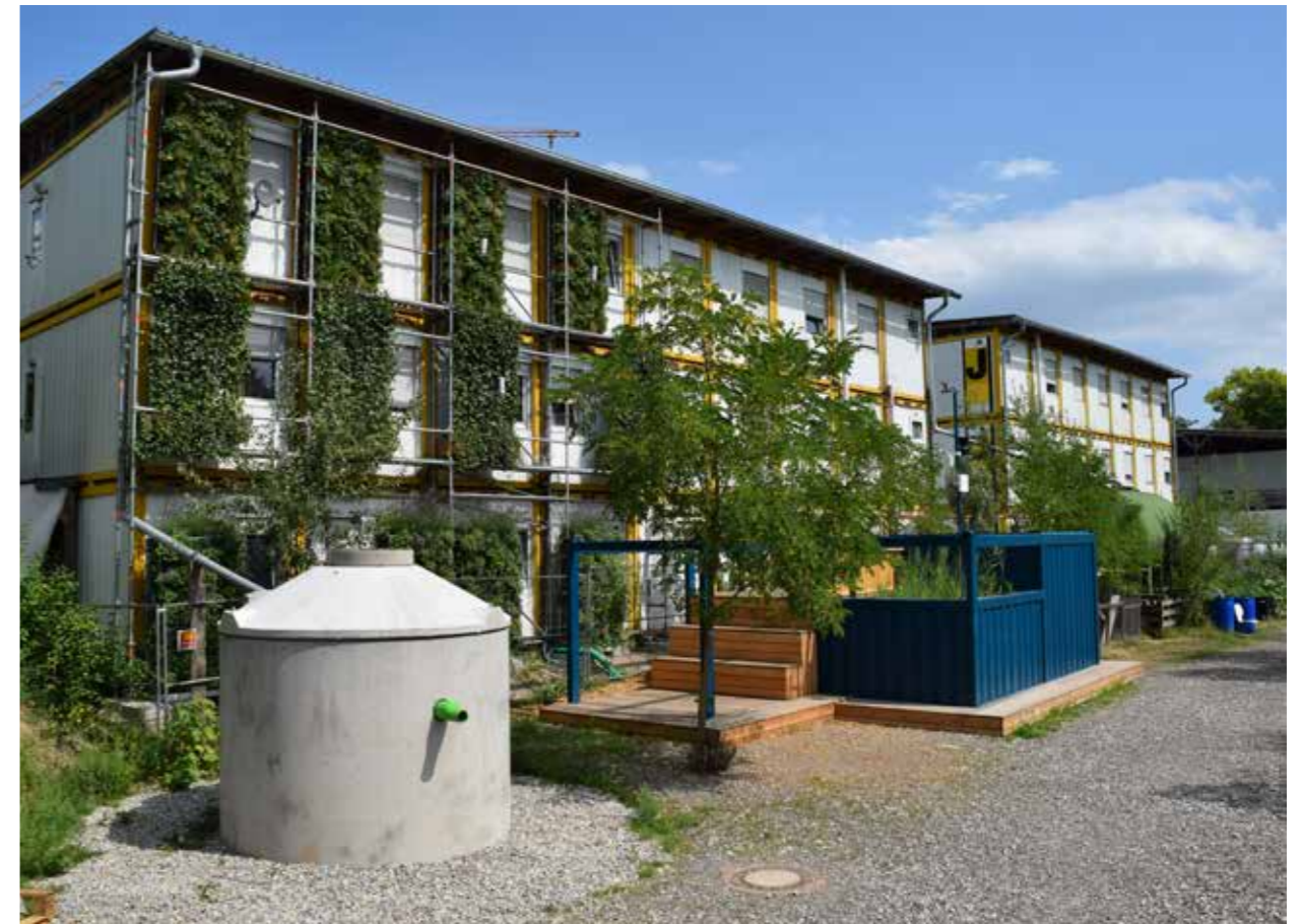
Abb. 46: Das Projekt „INTERESS-I“ in Stuttgart mit Fassadenbegrünung und Brauchwassernutzung. Quelle: BuGG
