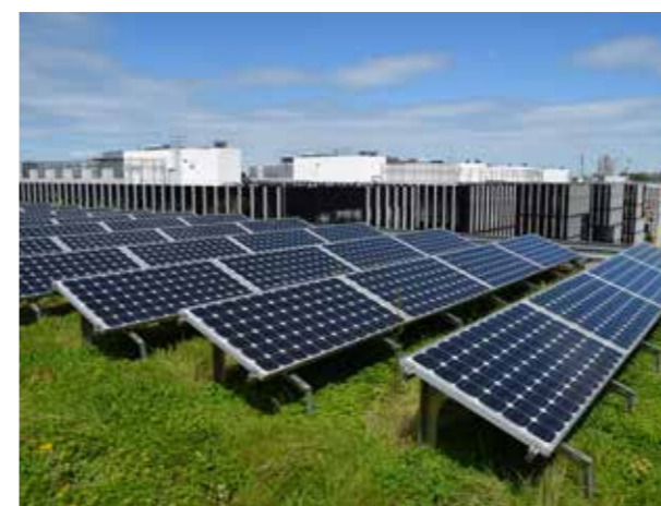
Abb. 43: Solar-Gründach. Kombination von Klimaschutz und Klimawandelanpassung. Quelle BuGG
