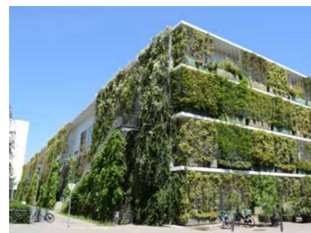
Abb. 27: In Deutschland wurden in 2020 etwa 45.000 m 2 bodengebundene Fassadenbegrünungen mit Kletterhilfen (links im Bild) und etwa 10.000 m 2 wandgebundene Fassadenbegrünungen (rechts im Bild) umgesetzt. Quelle: BuGG
