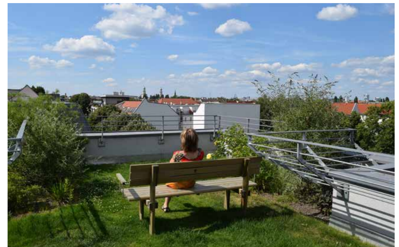
Abb. 21: Die Entwicklung der letzten Jahre geht in Richtung Intensivbegrünung, also genutzten Dachgärten. Quelle BuGG
