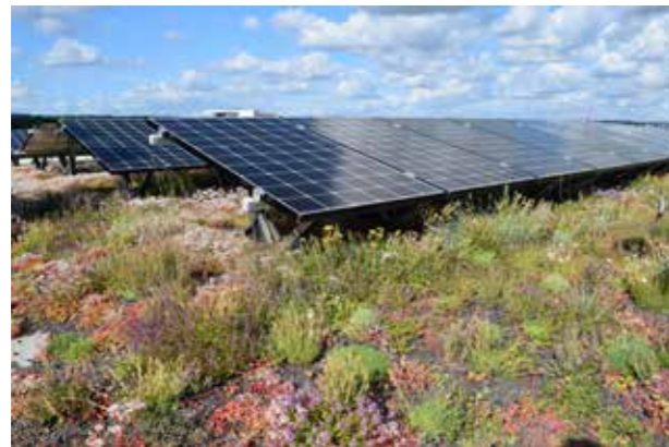
Abb. 4: Extensive Dachbegrünungen u. a. als Lebensraum für Insekten. Quelle: BuGG
