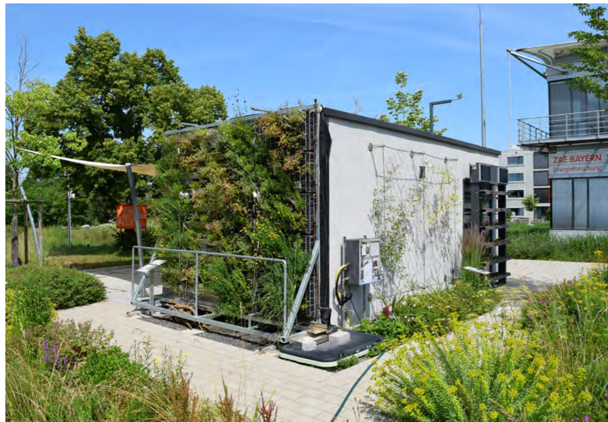
Abb. 69: In Sachen Forschung zur Gebäudebegrünung haben wir in Deutschland wieder zugelegt. Hier beispielhaft die Versuchsanlage zur Fassadenbegrünung der CAE Würzburg. Quelle: BuGG
