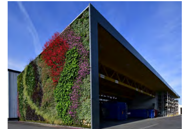
Abb. 21: Statt einer intensiven Dachbegrünung eine Living Wall an die Fassade gesetzt. Quelle: Skygardens AG & Leistungsfotografie.ch
