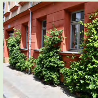
3 Bodengebundene Fassadenbegrünung
