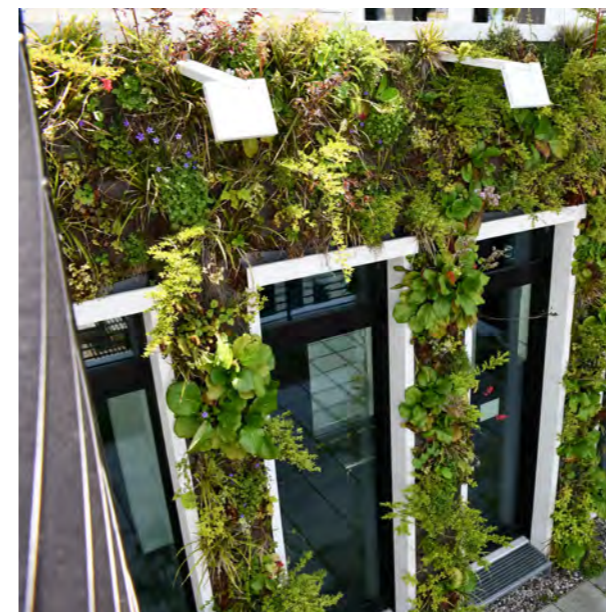
Abb. 52: ... ebenso wie wandgebundene Fassadenbegrünungen. Hier lassen sich die Flächen in Quadratmeter gut ermitteln. Quelle: BuGG
