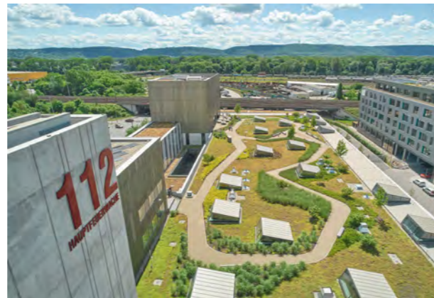
Abb. 19: Das BuGG-Gründach des Jahres 2022: Der genutzte Dachgarten der Hauptfeuerwache Karlsruhe. Quelle: Bauder
