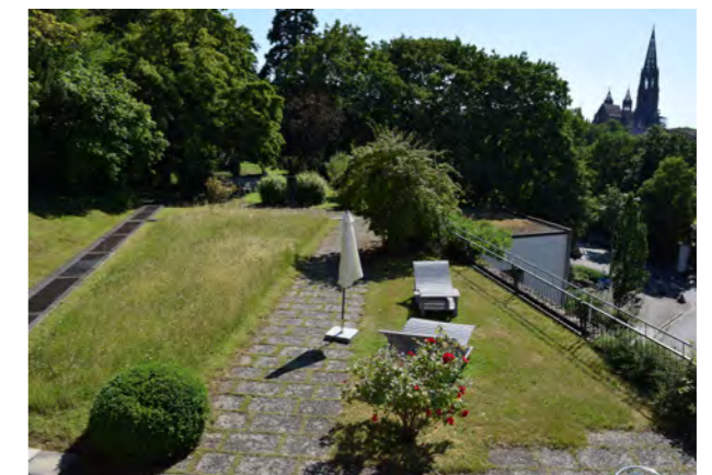
Abb. 48: Ein Dachgarten in Freiburg - eine jahrzehntealte und immer noch funktionsfähige Dachbegrünung. Quelle: BuGG
