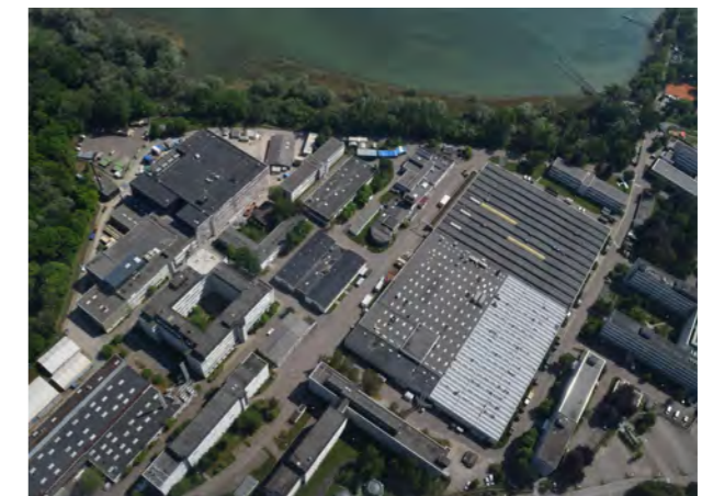
Abb. 38: Ein Blick aus der Vogelperspektive (hier Nähe Bodensee) verdeutlicht es - nur ein geringer Anteil der Dächer in Deutschland ist begrünt. Quelle: BuGG
