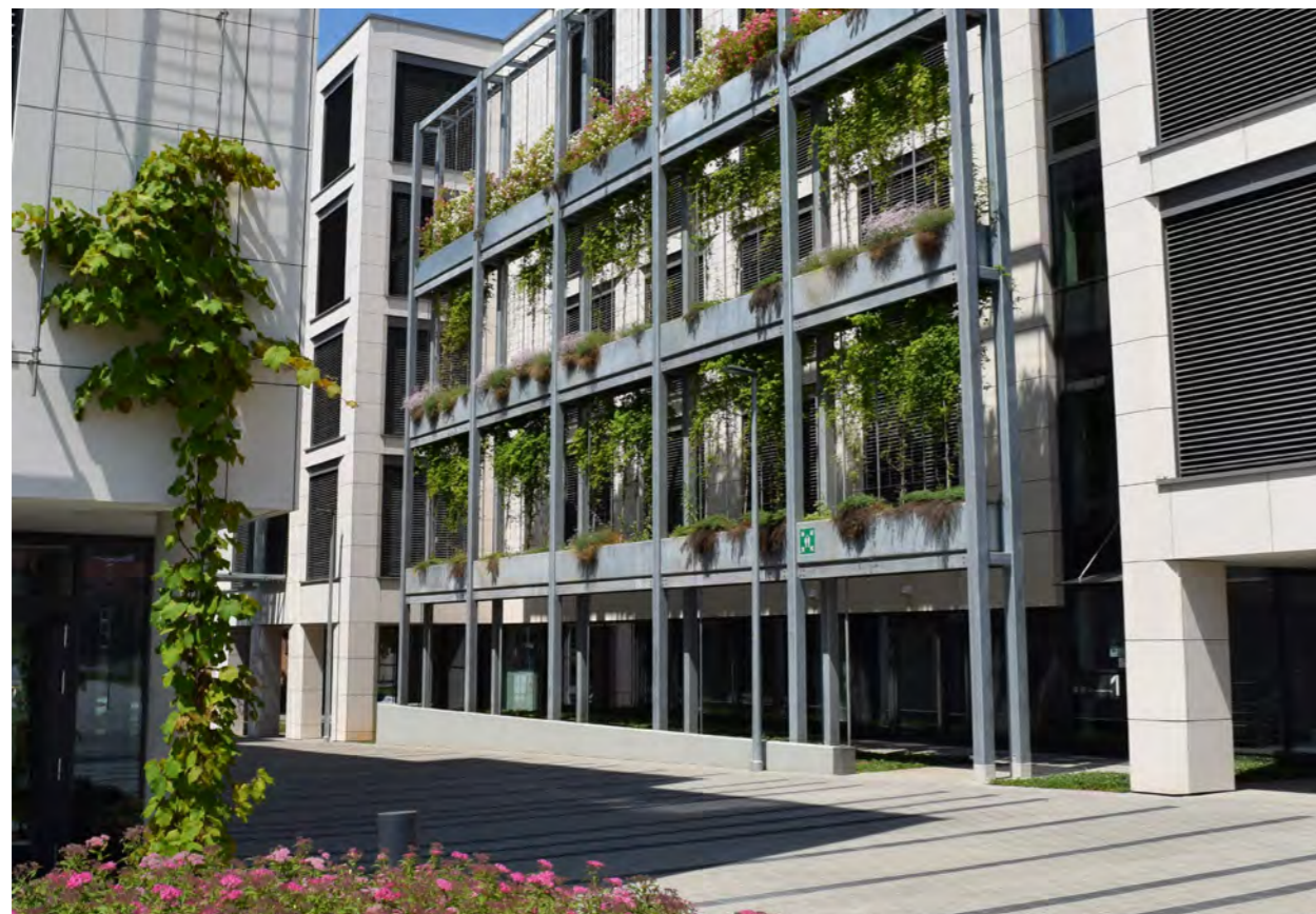
Abb. 49: In Deutschland wurden in 2022 etwa 115.800 m 2 bodengebundene Fassadenbegrünungen mit Kletterhilfen (links im Bild) und etwa 30.200 m 2 wandgebundene Fassadenbegrünungen (rechts im Bild) umgesetzt. Quelle: BuGG
