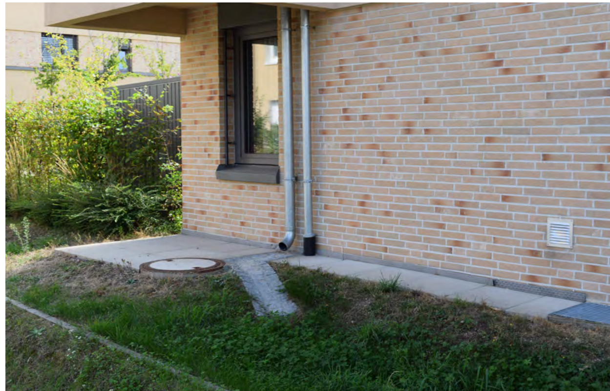
Abb. 67: Ziel der indirekten Förderung mit gesplitteter Abwassergebühr ist es, die Kanalisation zu entlasten - und ein Gründach hält zwischen 40 und 99 % des Jahresniederschlags zurück und das Überschusswasser kann z. B. einer Versickerungsmulde zugeführt werden. Quelle: BuGG
