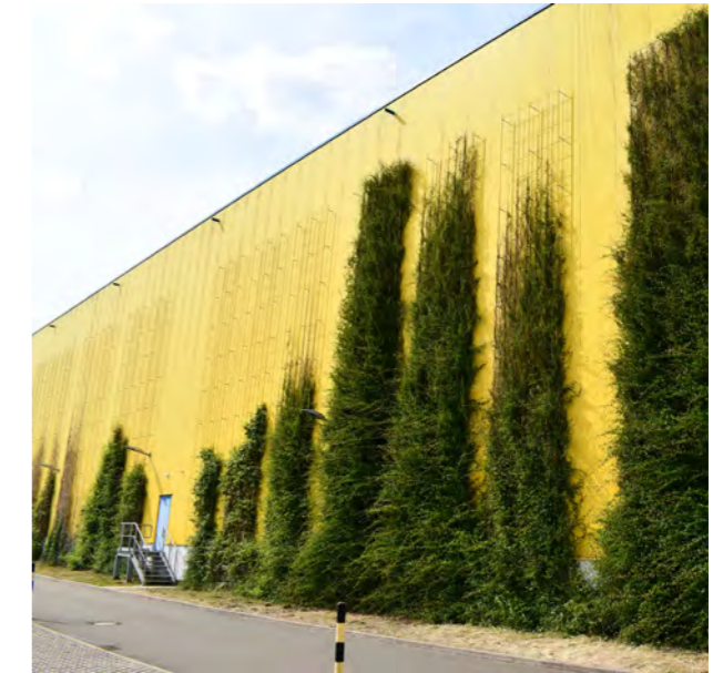
Abb. 51: Bodengebundene Fassadenbegrünungen mit Netzen bzw. Gittern lassen sich theoretisch gut erfassen ... Quelle: BuGG
