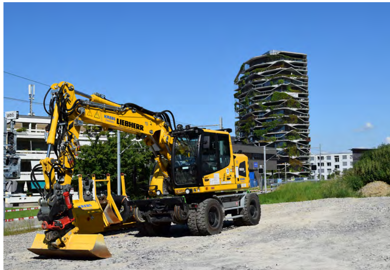
Abb. 65: Gebäudebegrünungen können bei Eingriffen in die Natur als Minderungsmaßnahme gelten. Quelle: BuGG
