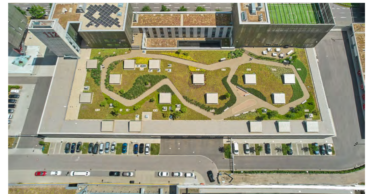
Abb. 18: Blick aus der Vogelperspektive auf das BuGG-Gründach des Jahres 2022: Feuerwache, Karlsruhe. Quelle: Bauder
