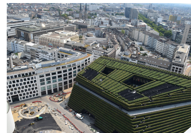
Abb. 1: Dach- und Fassadenbegrünungen sorgen für Verdunstungskühlung und Erhöhung der Luftfeuchtigkeit. Quelle: BuGG
