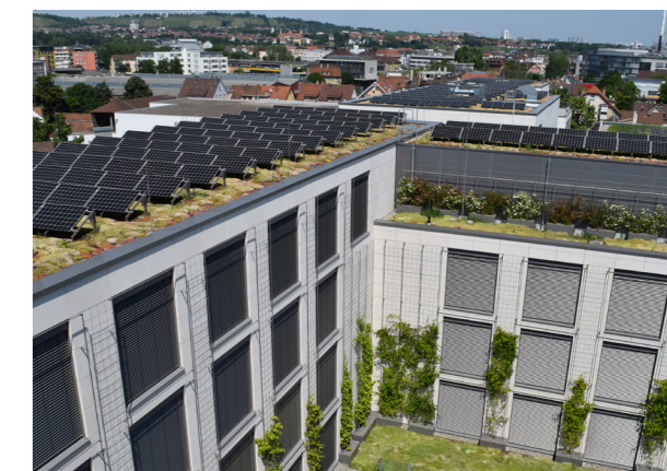
Abb. 8: Zukunftsträchtige Kombination Klimaschutz und Klimawandelanpassung: Solar-Gründächer. Quelle: BuGG
