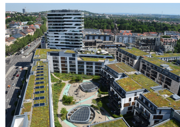
Abb. 3: Gebäudebegrünung: Verbesserung des Stadtbildes und Regenwasserbewirtschaftung. Quelle: BuGG
