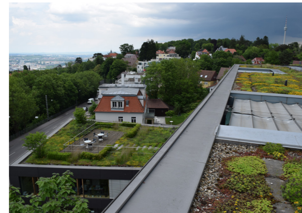
Abb. 2: Regenwasserbewirtschaftung mit Dachbegrünung. Quelle: BuGG
