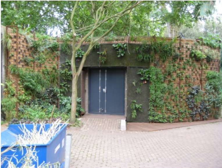
(BILD 5: Wandkonstruktion mit einmonatiger Bepflanzung)
