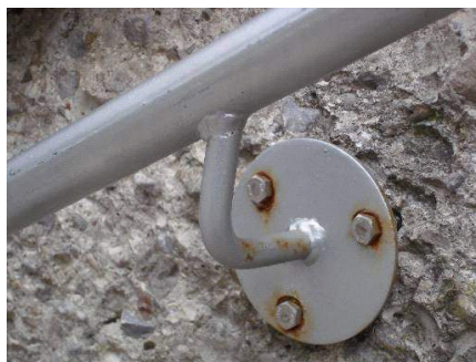
Korrosion von im Außenbereich verwendeter Dübel aus verzinktem Stahl.
