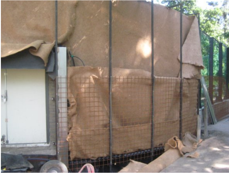
BILD 4: Wandkonstruktion mit Kokosflies
