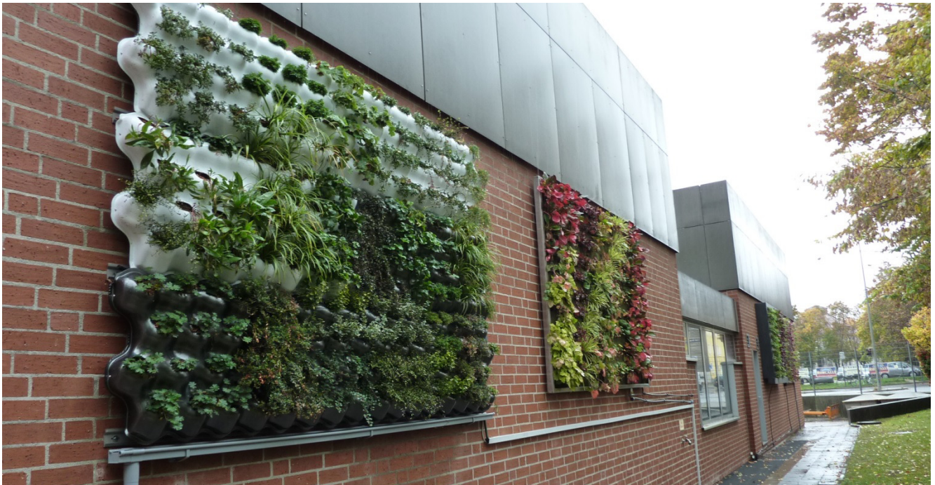
Bild 1: Die Versuchsanlage mit 4 Systemherstellern in der Muggenhofer Straße in Nürnberg im Oktober 2013
