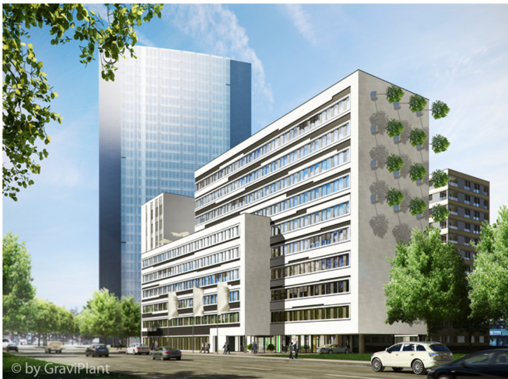
Abb. 5 Fassadengestaltung mit GraviPlants
