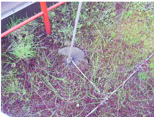
Bild 14: fast eingewachsene Fangeinrichtung (Quelle: Gepla mbH & Co. KG)
