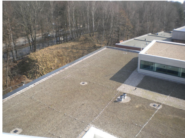
Bild 6: Fangmasche auf Flachdach (Quelle: Gepla mbH & Co. KG)
