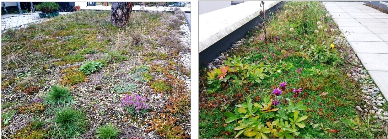
Abbildung 3: Mit gebietseigenen Herkünften begrünte Dachflächen auf dem Bürogebäude der Baader Konzept GmbH, Gunzenhausen/Mfr., 2 Jahre alt (Lavaterr-Dachbegrünungssubstrat, 12-14 cm, einschichtig, gekalkt, Aufnahme Oktober 2015)
