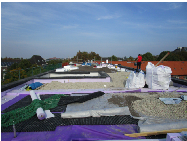
Abb. 3: Extensive Dachbegrünung in der Bauphase
