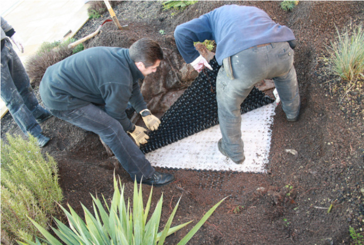
Abb. 5: Probeentnahme bei einer Objektuntersuchung Wassergehalt in der XPS-Platte Objekt Köln-Rodenkirchen
