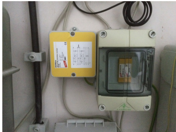
Bild 11: Überspannungsschutz für die Informationstechnik (Quelle: Gepla mbH & Co. KG)
