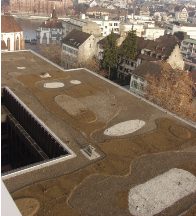
Bild 1: Die neu eingerichtete Dachbegrünung Klinikum 2 auf dem Universitätsspital Basel. Verschiedene Substrate aus dem umgebenden Naturraum in unterschiedlicher Schichtung sollen ein naturnahes Ersatzhabitat für die zerstörten Flussufer des Rheins (im Hintergrund) ergeben. Foto: Stephan Brenneisen
