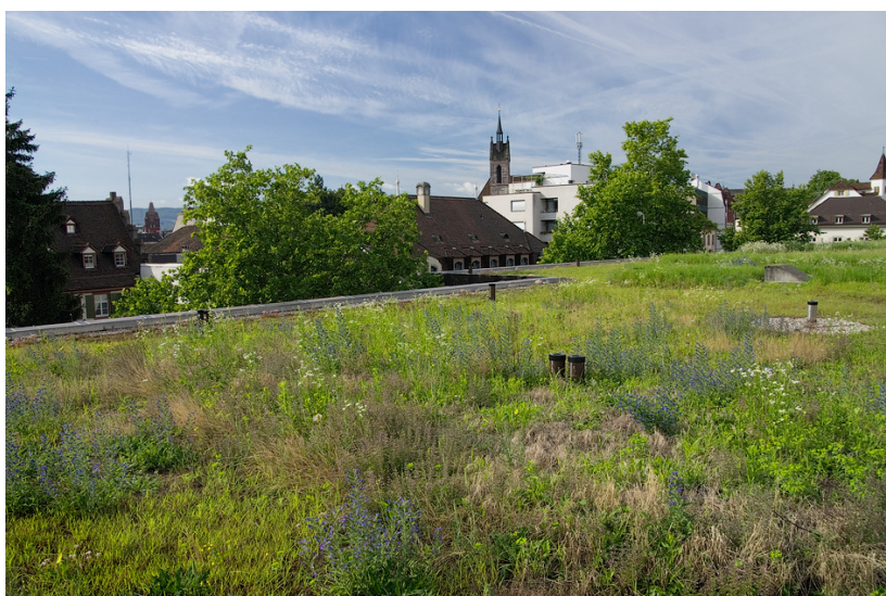
Abb. 7: Dachwiese auf dem Universitätsspital Basel: Stadtökologisch optimal wirksame extensive Dachbegrünung. Foto: Stefan Grossert.
