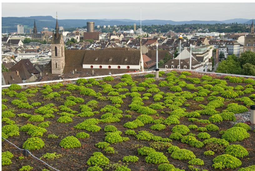
Abb. 6: Dachbegrünung mit dünnem Aufbau und dadurch geringem Bewuchs. Die stadtökologische Wirkung ist reduziert. Foto: Stefan Grossert.
