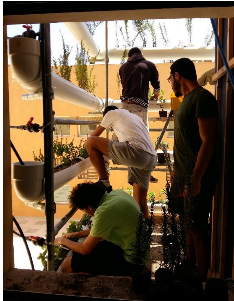
Zugang über Fenster zum Balkongarten ermöglicht Konstruktionen für Bestandsgebäude
