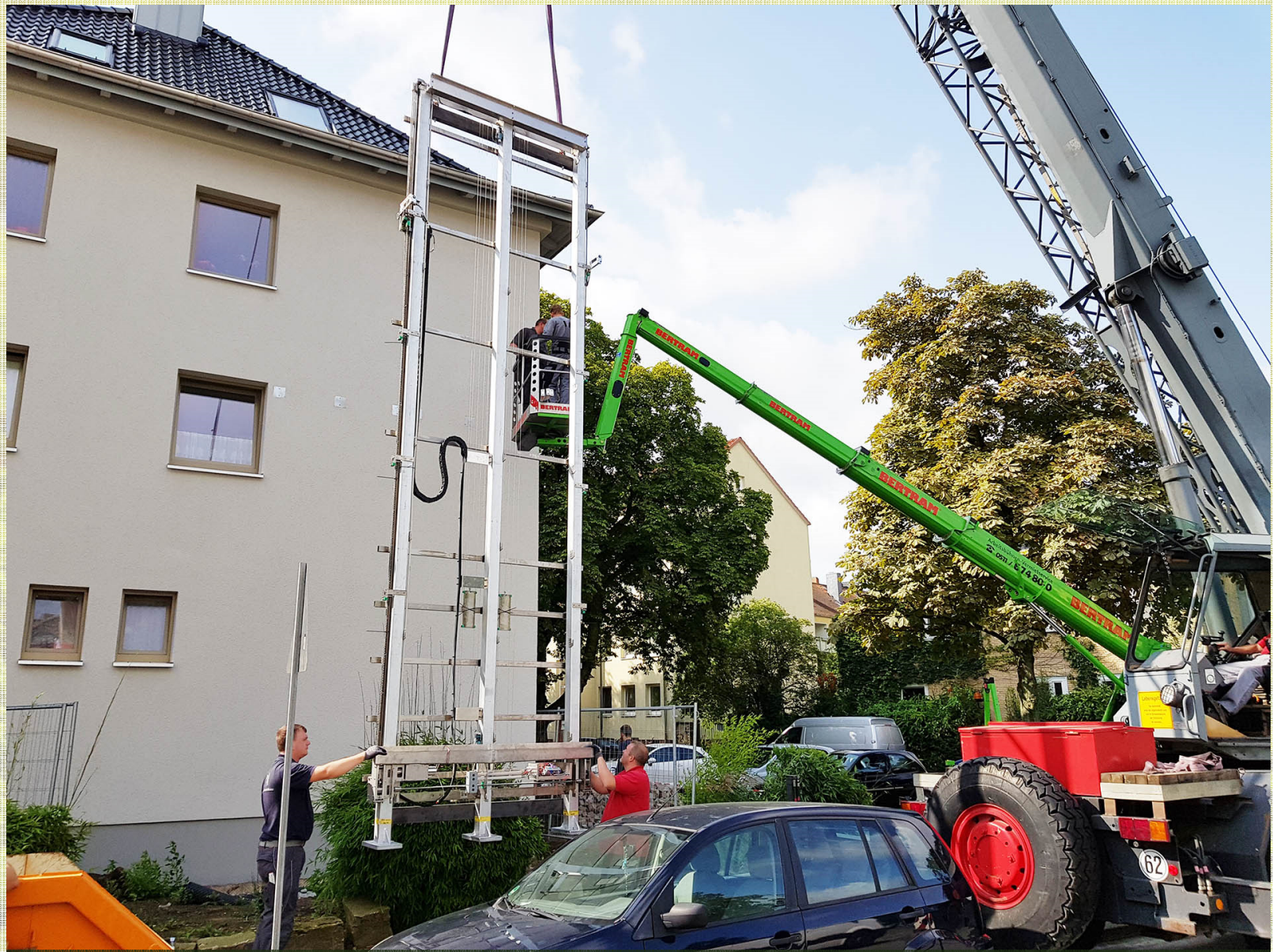
Installation einer Moosmaschine - Gewicht ca. 500 kg
