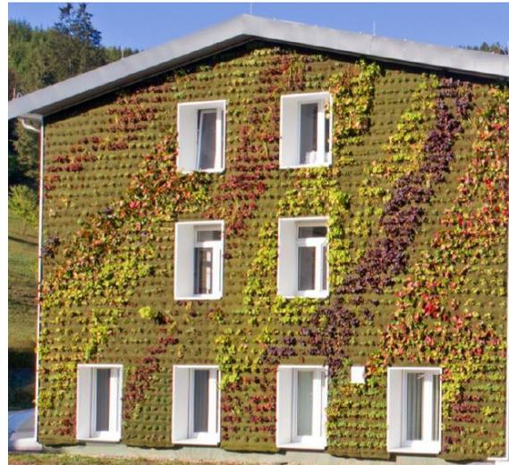
Abb. 4: Fassadenbegrünung der Fa. Vertiko nach GLT Belke/Vertiko 2019, verändert)
