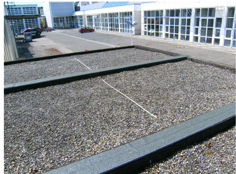
Garagen mit Kiesdächern
