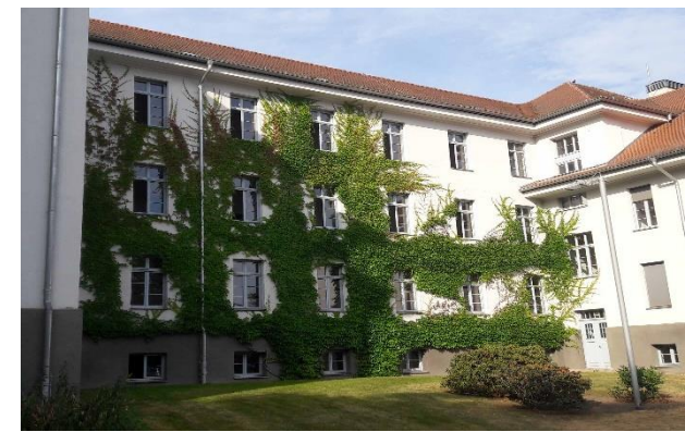
Foto: LHD, Arbeitsgericht Dresden, Hans-Oster-Straße
