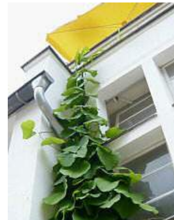
Abb. 76: Pfeifenwinde (Foto: © fassadengruen.de)
