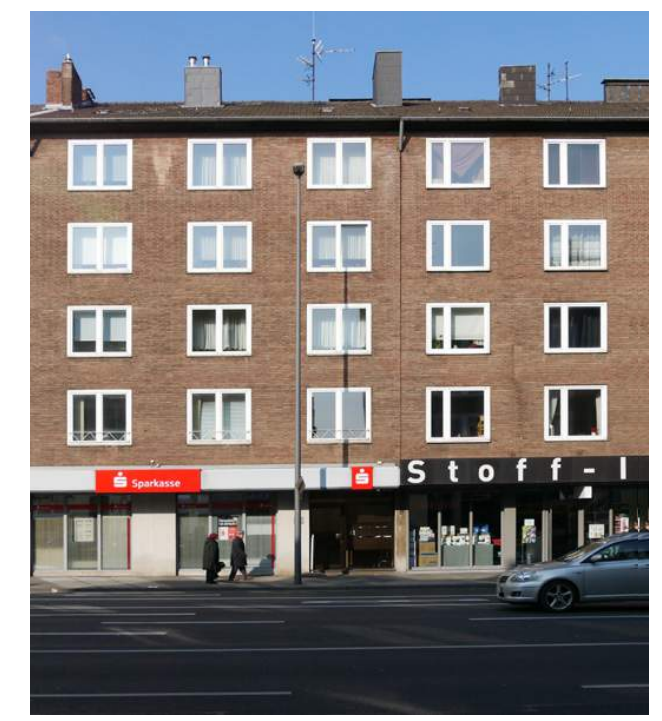
Abb. 71: Lochfassade, Adalbertsteinweg (Sandra Sieber 2016)
