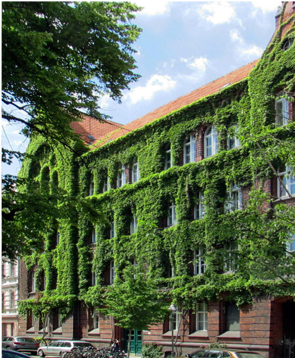
Fassadenbewuchs mittels Selbstklimmern
