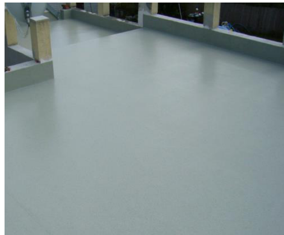
kombiniert (begehbare Abdichtungssystem)
