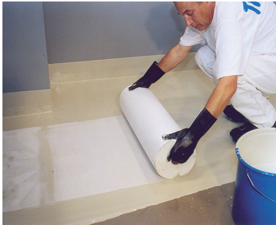
mit Vlieseinlage... (Abdichtung)
