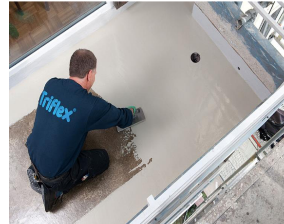
ohne Vlieseinlage (Beschichtung)
