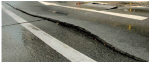
Überlauf des verrohrten Briller Bachs unter die Straßendecke nach Starkregen (2008)
