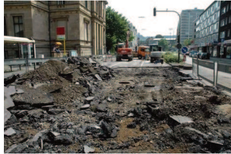
Überlauf des verrohrten Briller Bachs unter die Straßendecke nach Starkregen (2008)
