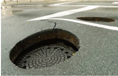
Überlauf des verrohrten Briller Bachs unter die Straßendecke nach Starkregen (2008)
