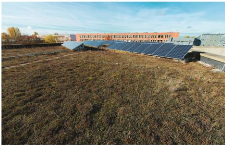
Photovoltaikanlagen auf dem begrüntem Dach des OSZ
