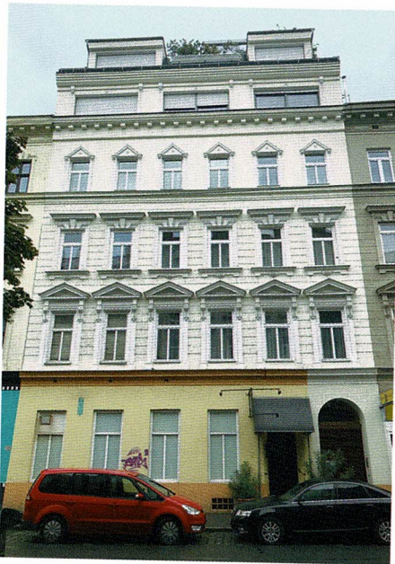
Das Gebäude mit noch unbegrünter Fassade ...
