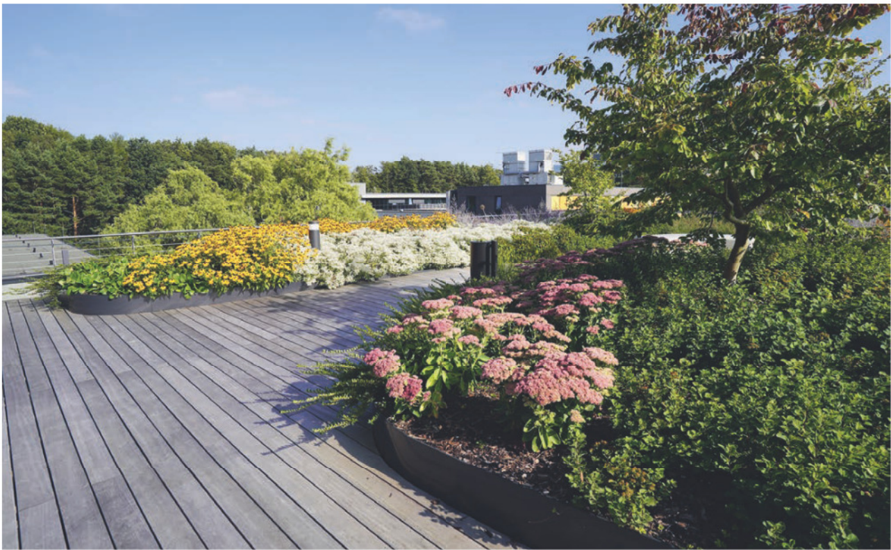
Metallaufkantung zum Ausgleich des Höhensprungs zwischen Terrassenniveau und Vegetationsflächenaufbau.
