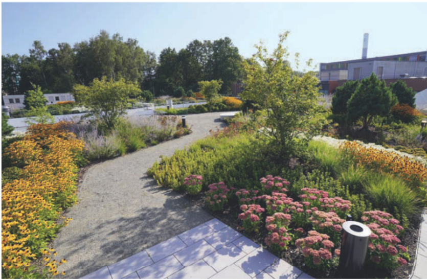
Wassergebundene Wegedecke, hier über dem zweiten Obergeschoss.
